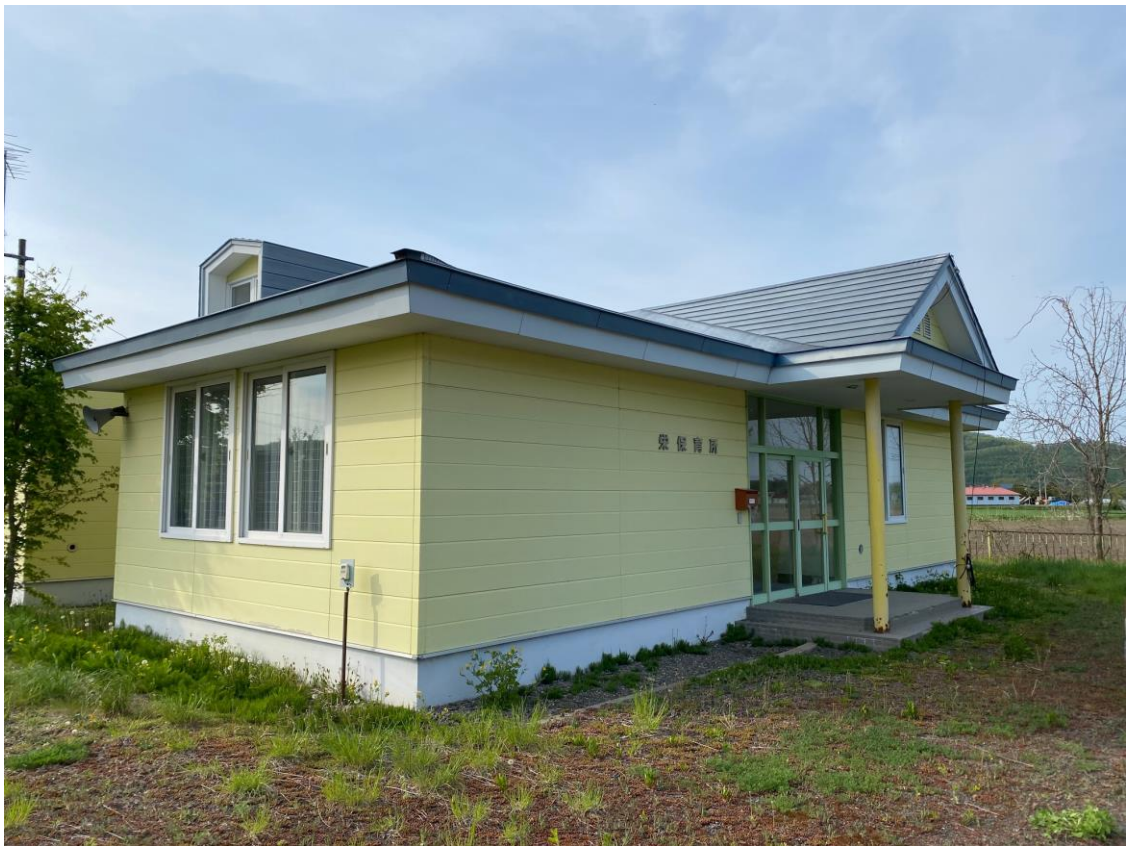
(旧栄保育所外観 令和5年5月撮影)
