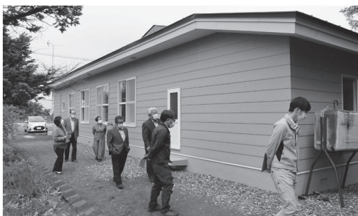
外壁など施設周辺を視察
