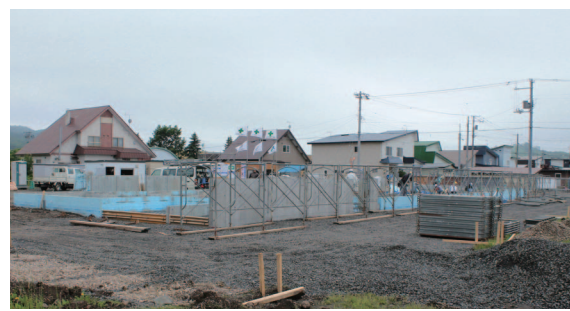
小田医院跡地に建設中の新たな高齢者福祉住宅
