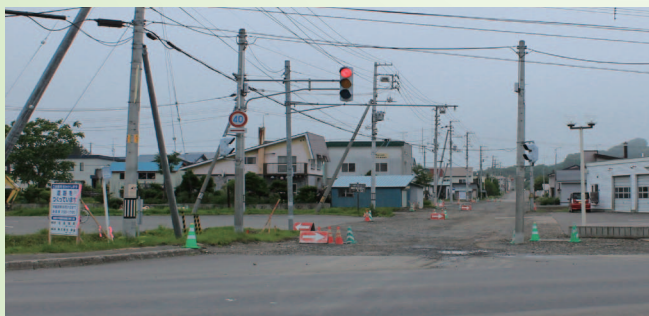
現在工事中の佐呂間30号道路
