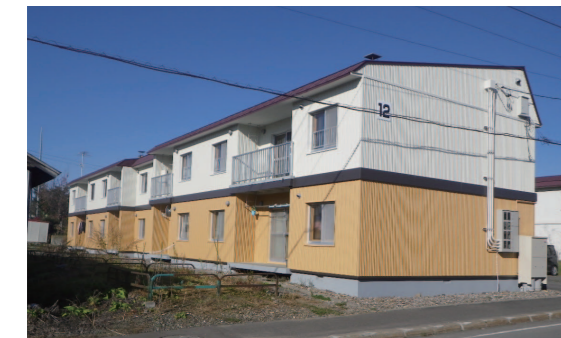
外壁改修をほどこした西富団地棟 (12号棟)
