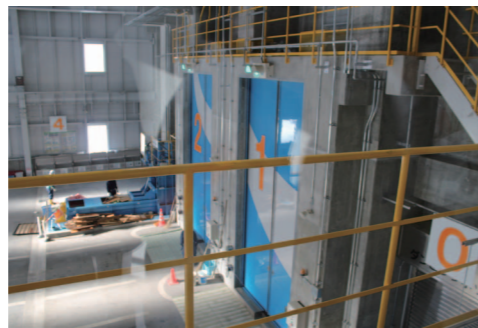
大きな扉の向こうでごみ処理が行われている
