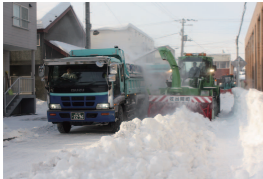
町道の除雪を業務委託により実施
