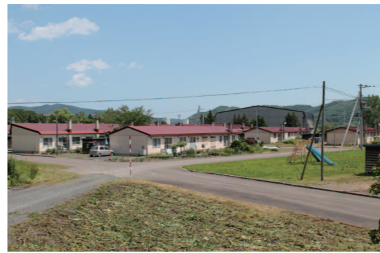
昭和40年代に建てられた緑園団地
