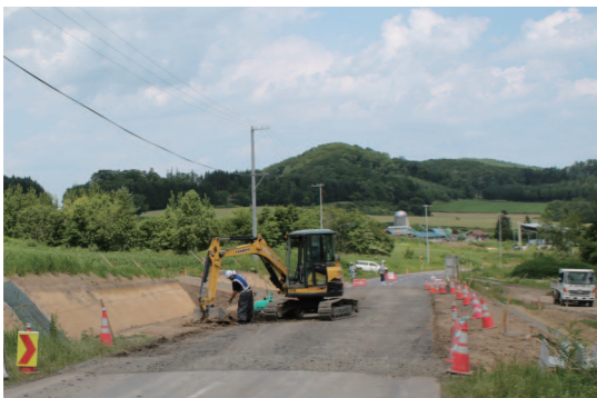
施工中の若里基線道路整備事業
