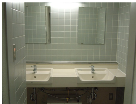
新設された若佐コミセン洗面所
