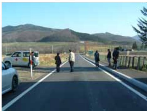
舗装となった 佐呂間高校裏通り道路
