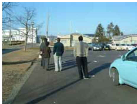
舗装となり使いやすくなった 佐呂間小学校駐車場
