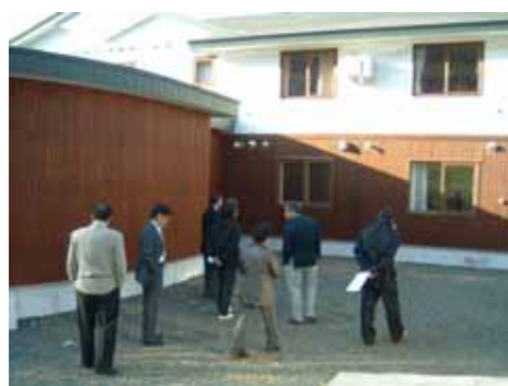
木部塗装を行なった悠林館
