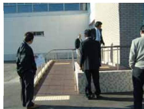
スロープが設置された 町総合体育館
